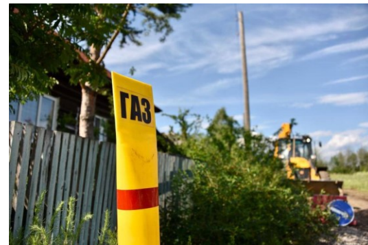
Ход строительных работ по догазификации микрорайона Левый берег Каквы в г. Серове
